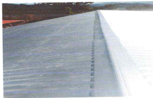
Foto2: Techo de lamina
