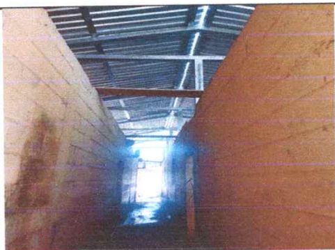
Foto3: canales y bajadas
